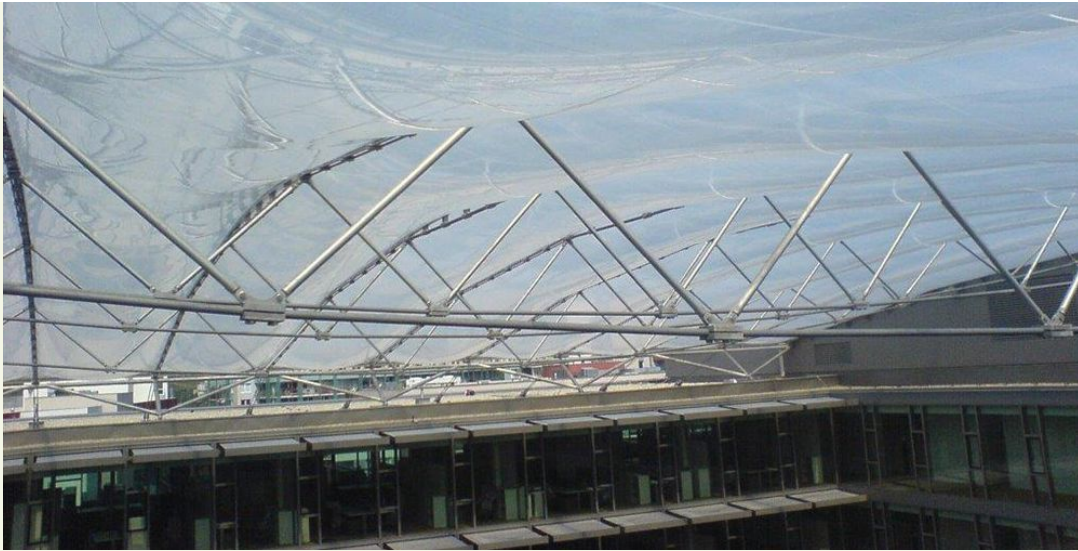
Sparkassen-Atrium, Bratislava ~ © Foto: T//O
