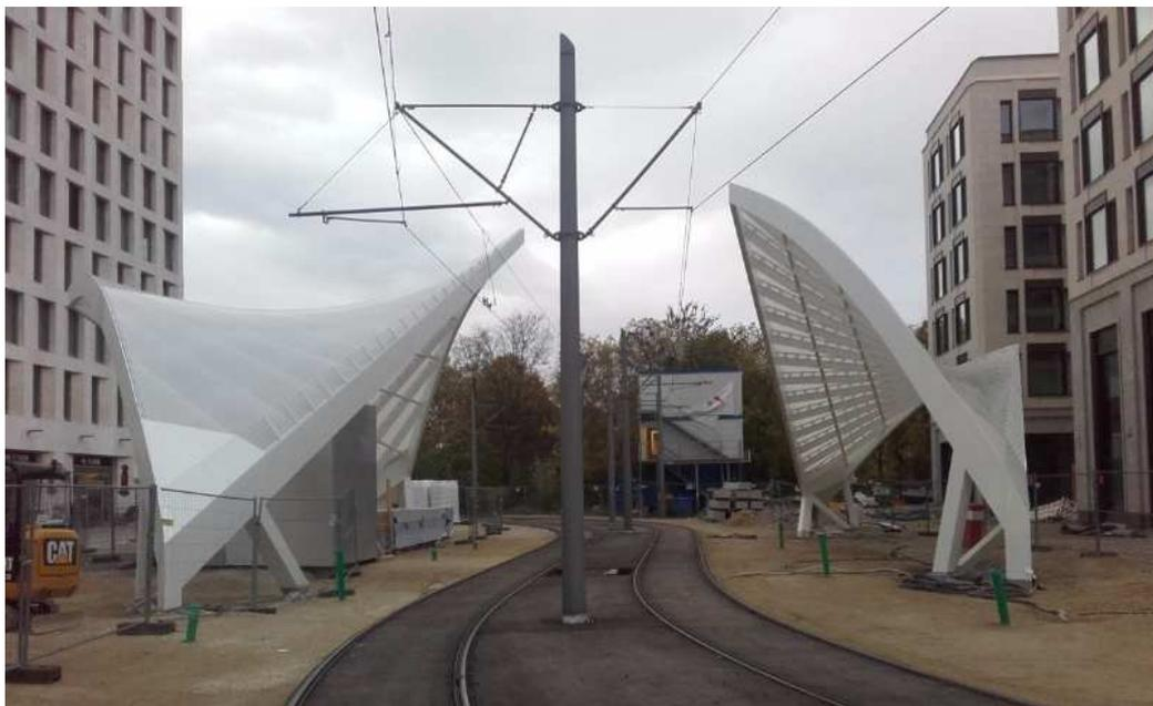
Trambahn-ETFE-Folienkissen-Dach „Schwabinger Tor“ in München © Foto: T//O
