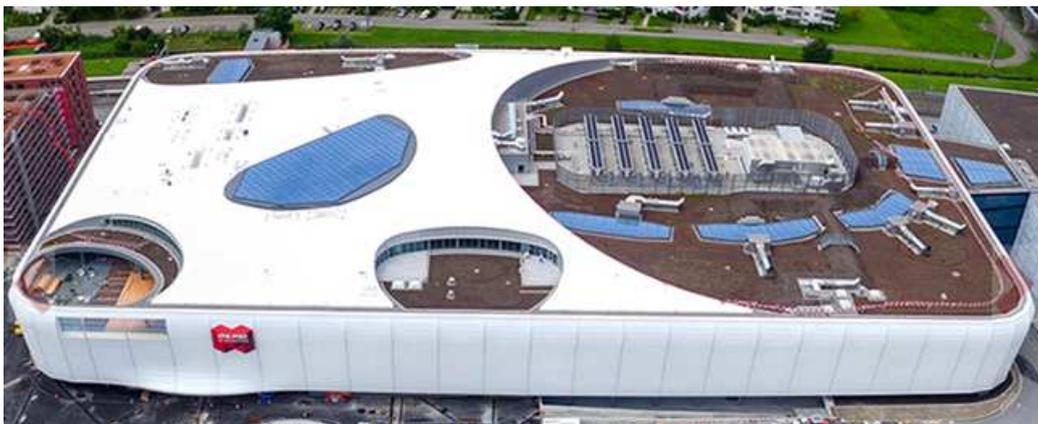
ETFE-Folienfassade einlagig & Stahl-Tragwerk Mall of Switzerland © Foto: T//O
