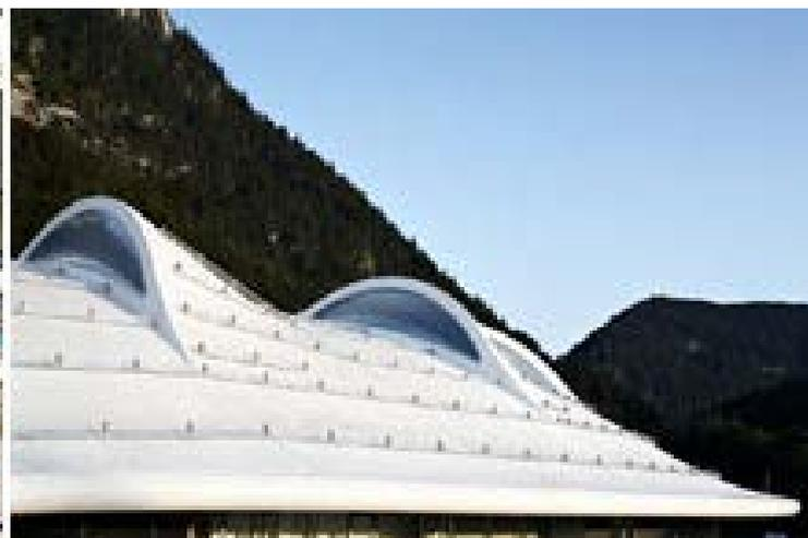
**Konfektionierung:** Wir beziehen die Materialien, wie z.B. ETFE-Folien, PTFE-Glas oder PVC. Diese Materialien werden dann entweder verschweißt, vernäht oder verklebt.
