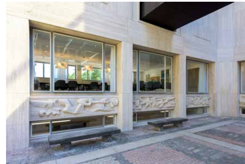
Nieuwe beglazing in bestaande deel, onder de taatskoepel.
